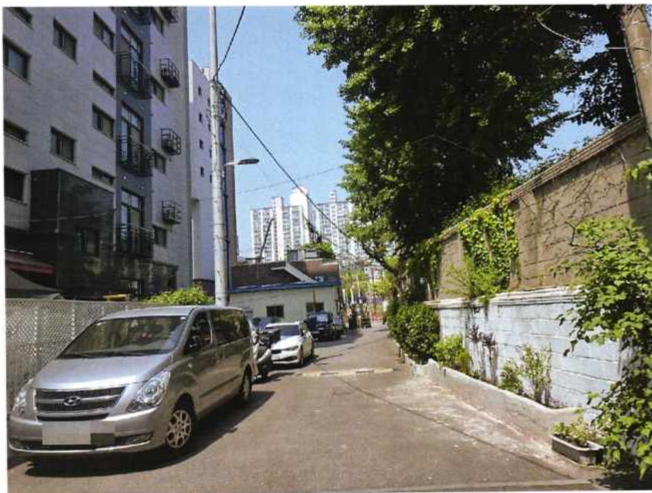
대상물건 인근도로 전경
